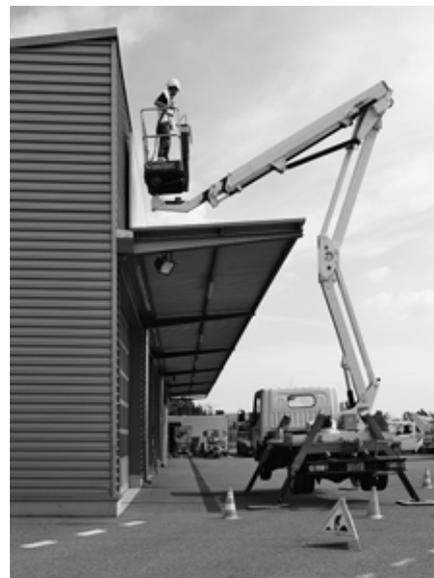
Fig. 8: il posto di lavoro deve essere messo in sicurezza in modo da evitare che i passanti entrino nella zona di pericolo della piattaforma.
