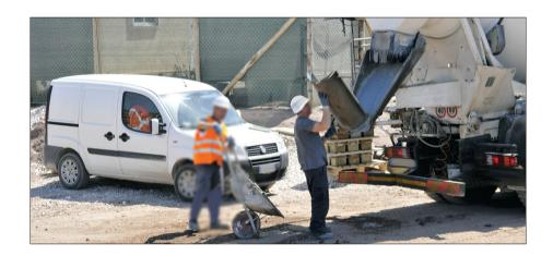
Operazioni di scarico 3/4 - in benna o secchione movimentato da gru
